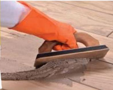
Emboquillador base cemento Portland, arena sílica y pigmentos especiales modificado con resinas en polvo, aditivos químicos y sellador integrado para rellenar juntas de 2 a 5 mm sin arena y de 3 a 15 mm con arena.
